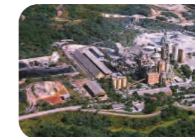
Tratamento de efluentes
