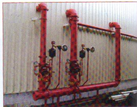
Sistema ranhurado: sem elementos de solda ou de rosca, montagem é até seis vezes mais rápida
